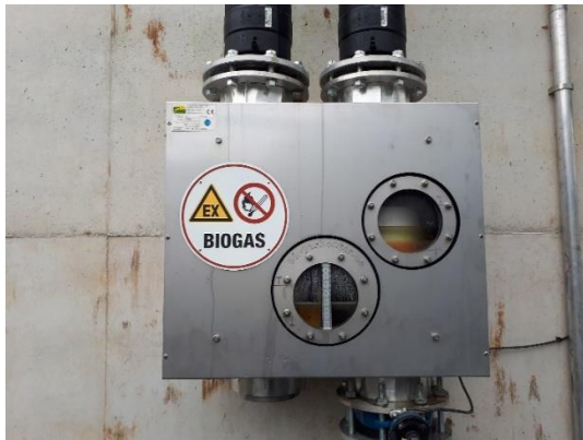
Figure 9 Représentation d'une soupape de sécurité
