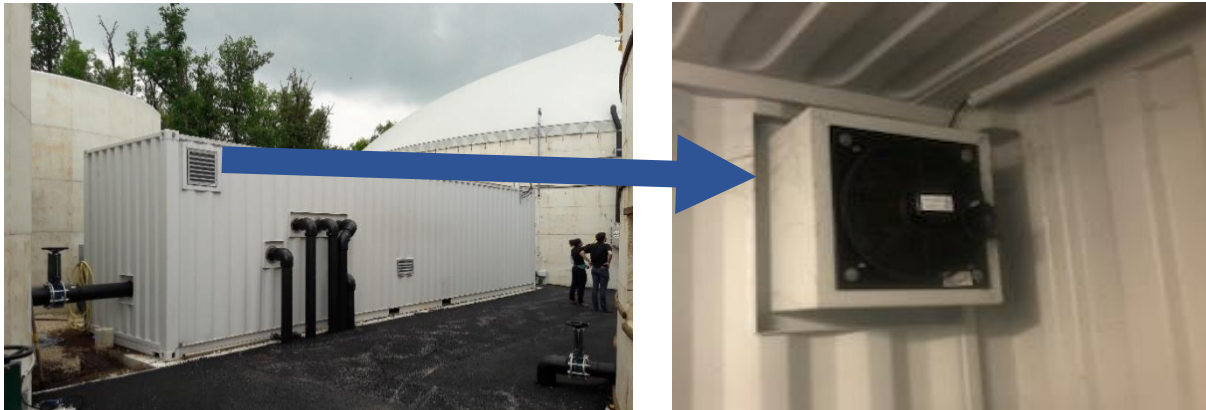
Figure 3 Représentation de la ventilation du local process
